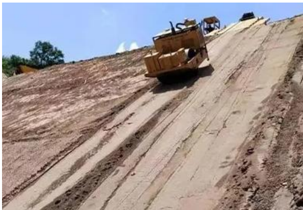
图7 工程施工拍摄图
